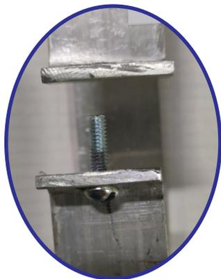
No estado normal de funcionamento da **Proteção Contra Raios Pioneiro**, **NÃO** deve haver faísca no **Parafuso Faiscador**, para isso, deve ser ajustado da seguinte forma:
